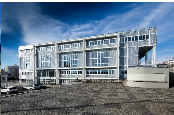
Budova po rekonstrukci, listopad 2023
