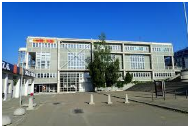
Budova před rekonstrukcí, rok 2021
